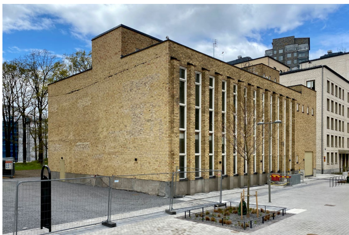
Befintlig sydfasad från sydost.
