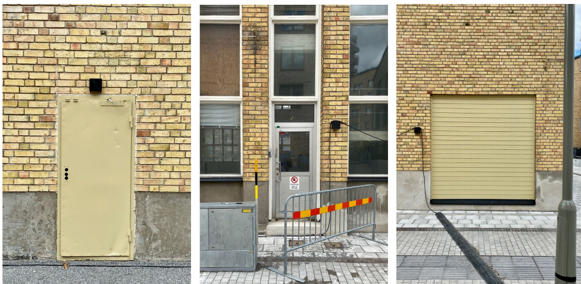
T.v. dörr i sydfasad som rivs. I mitten dörr som ersätts av fönsterparti med uppmurad sockel. T.h. igensatt lastport som ersätts av utökad plåtklädd nisch och två enkeldörrar i stål.
